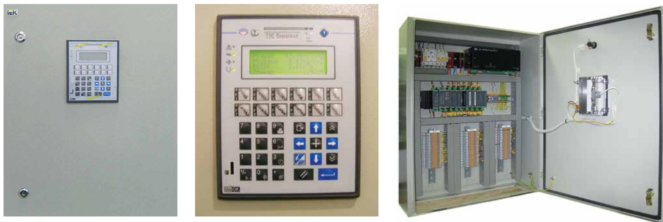
Рис. 2. Щит САУ ГРС МП-01 (вид снаружи и изнутри)
