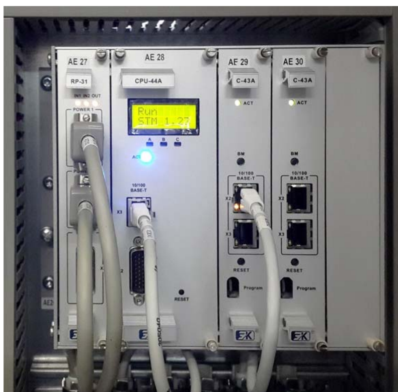
Рис. 2.13. Пример размещения модулей в крейте контроллера DCS-2000 (M3) на 13 платомест
